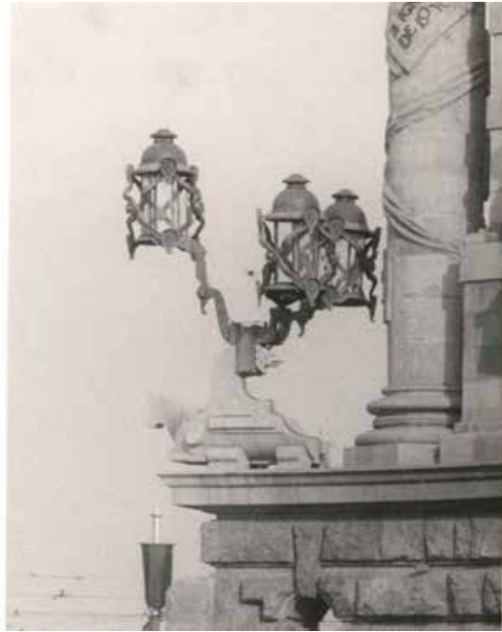
Element ornamental de pedra per subjecció de les il·luminàries de ferro i bronze, adopten la forma de cartela, amb detalls geomètrics i antropomòrfics.
