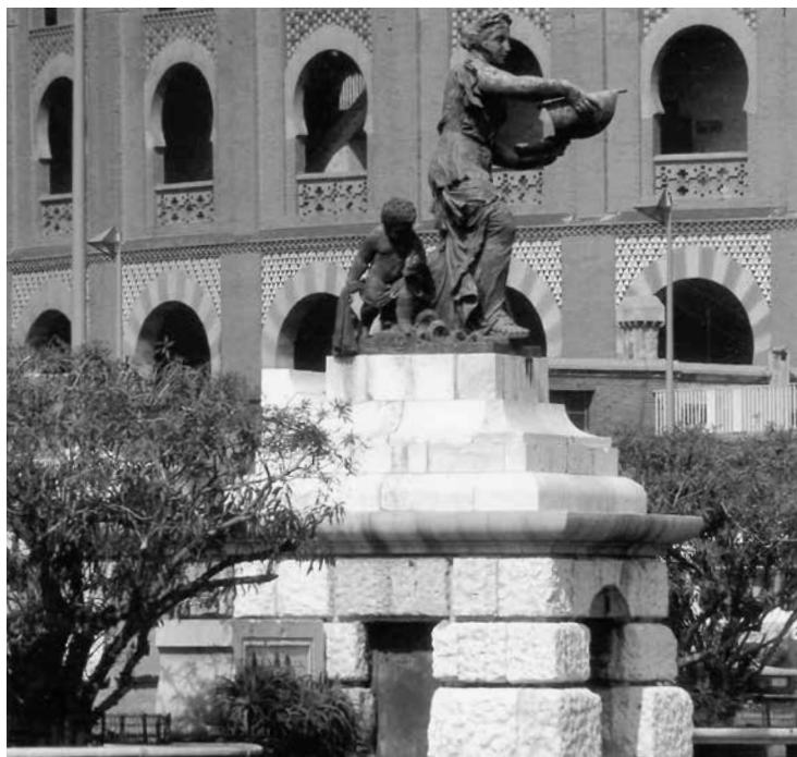
Visió d'un pedestal de grans dimensions amb diferents tipus de despejament i acabat de pedra situat a l'extrem del sòcol que presenta una doble funció: una de tipus funcional per a situar una entrada de serveis i una altra de tipus ornamental per la col·locació d'un conjunt estructural.
