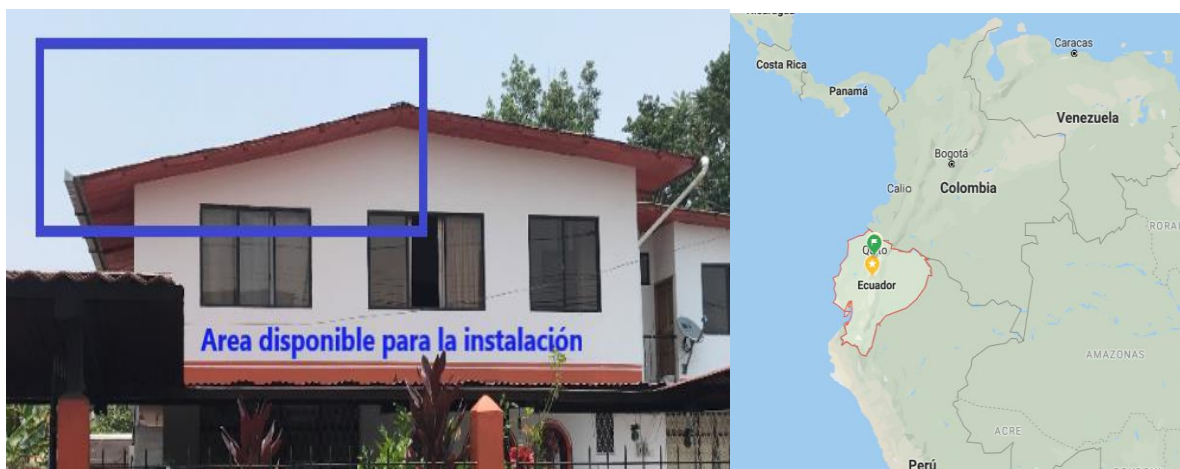
Figura 4.1. Tejado disponible para la instalación de los paneles de generación PV.
