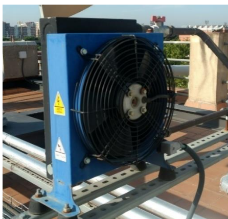
Figura 3.12. Intercanviador de calor extern [font pròpia]
