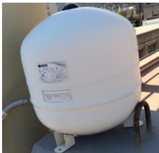
Figura 3.16. Vas d'expansió circuit secundari [font pròpia]
