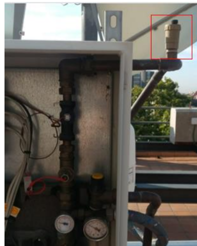
Figura 4.7. Purgador sortida HCU [font pròpia]
