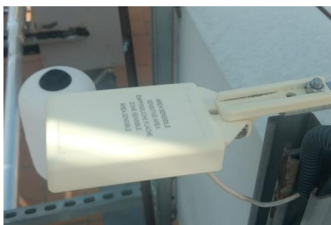
Figura 3.6. Sensor de pluja [font pròpia]
