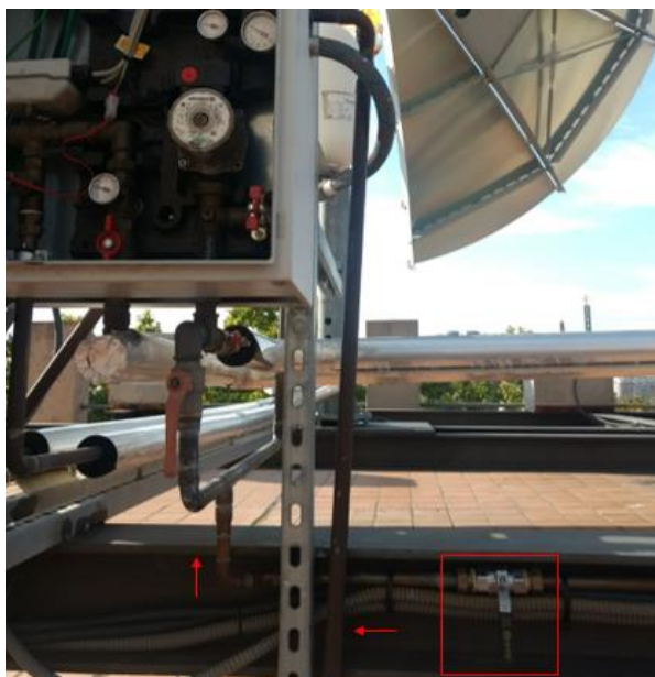
Figura 4.8. Muntatge d'ompliment del circuit hidràulic [font pròpia]
