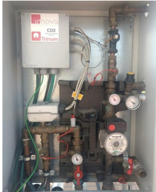
Figura 3.10. Unitat de Control Hidràulic (HCU) [font pròpia]
