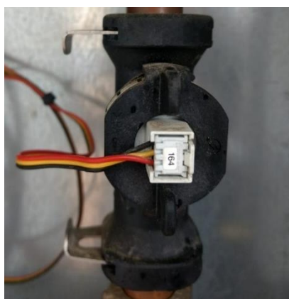
Figura 3.8. Cabalímetre fluid refrigerant [font pròpia]
