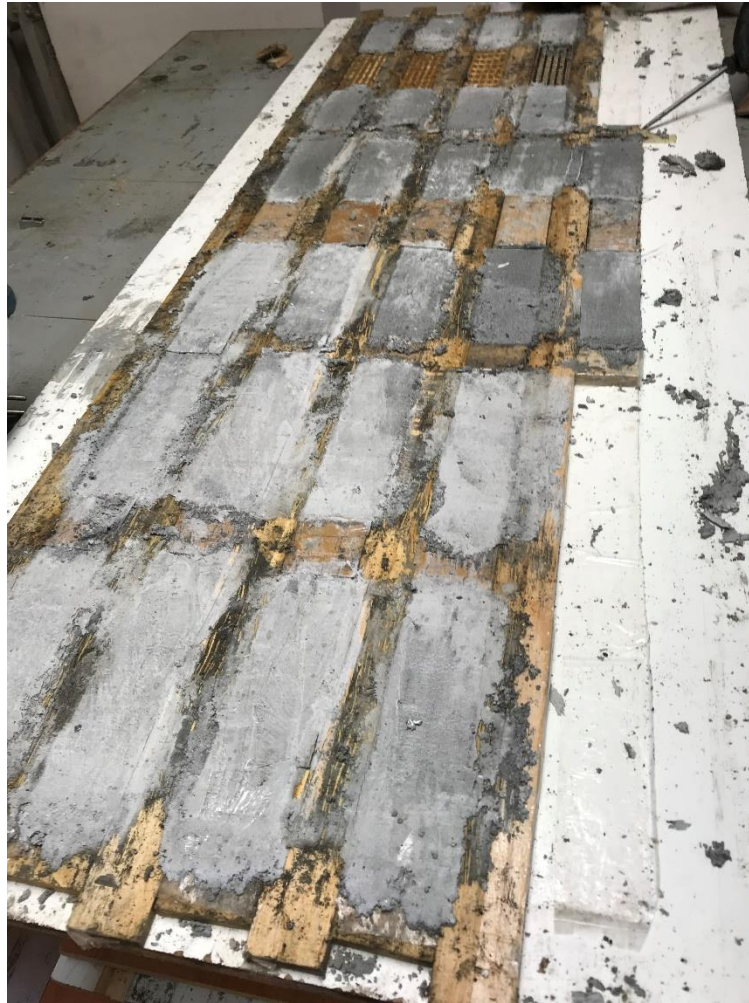
Figura 29. Procés de desencoframent del motlle
