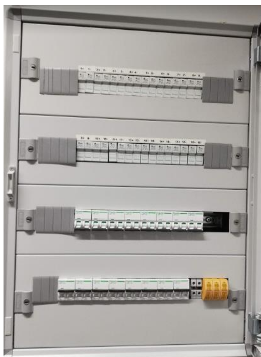
Figura 3.7. Interruptors que connecten amb els parells de panells ubicats a la terrassa de la EEBE. Fotografia de l'autor
