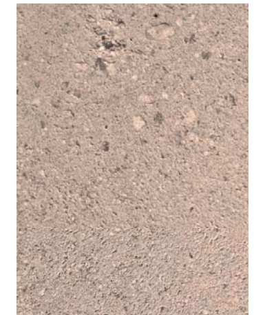
Pilar central de formigó de calç amb acabat de raig de sorra
