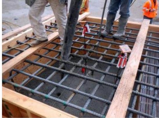
*Ilustración 4-9 Sensores de temperatura en una loseta*
