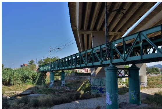
Figura 3.7. Pont "Eiffel" sobre el riu Ripoll. Els viaductes de la C-33 creuen al mateix temps el riu i la via. Elaboració pròpia.
