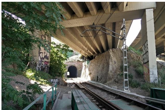
Figura 3.6. Boca nord del túnel del Fermí. S'aprecia el pòrtic de sustentació del viaducte de la C-33 i l'inici del pont sobre el riu Ripoll. Elaboració pròpia.
