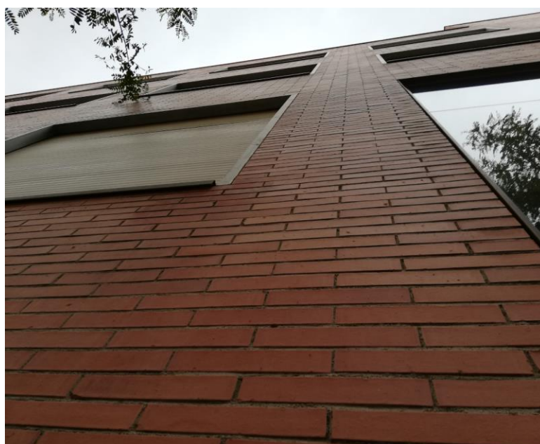
Fotografía 4.1 Fachada del edificio D6.
