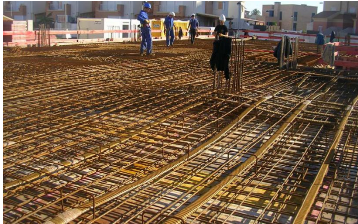
Losa postensada en proceso de construcción, con las vainas colocadas antes de verter el hormigón. Edificio de oficinas en Gandía (Valencia), con luces de hasta 13 m con cantos de 35 cm. Fuente: Freyssinet, 2012
