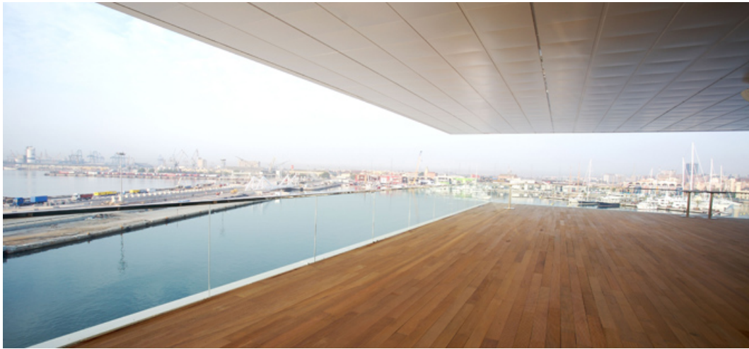
Vista del puerto de Valencia, bajo el voladizo postensado del edificio "Veles e Vents" para la Copa América de Valencia 2007. Fuente: B-720, 2007
