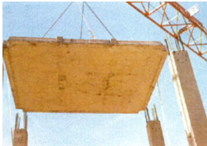
Sistema yugoslavo de losas prefabricadas, que se unen a pilares prefabricados mediante postesado. Fuente: IMS, 2009
