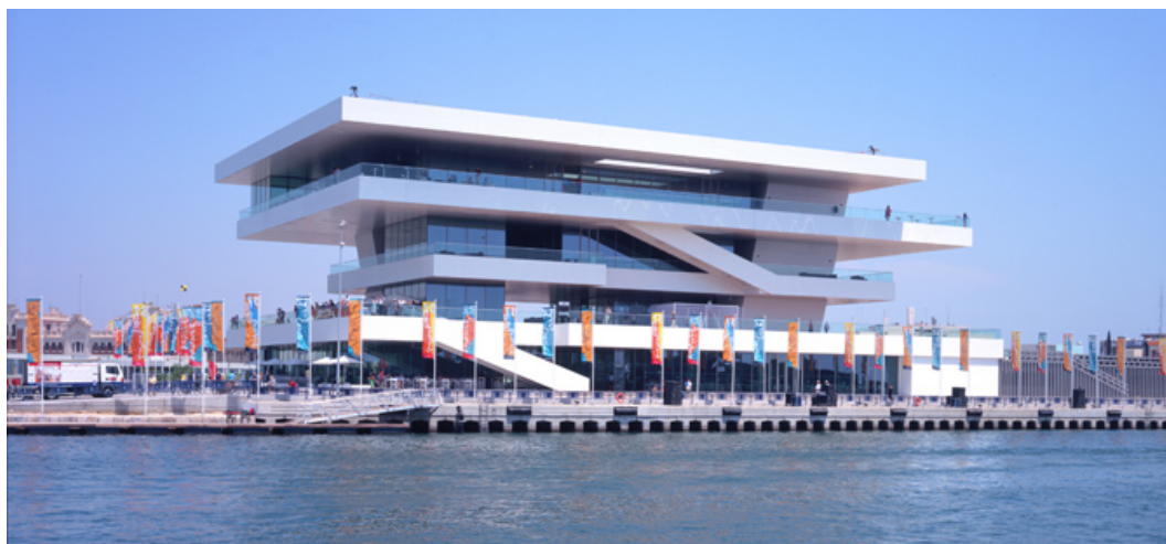
Edificio Veles e Vents, con voladizos de 12 m y luces entre apoyos de 35 m. Fuente: B-720, 2007
