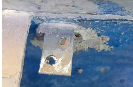
Figura 108. Soporte cubierta central (Fuente: Propia)
