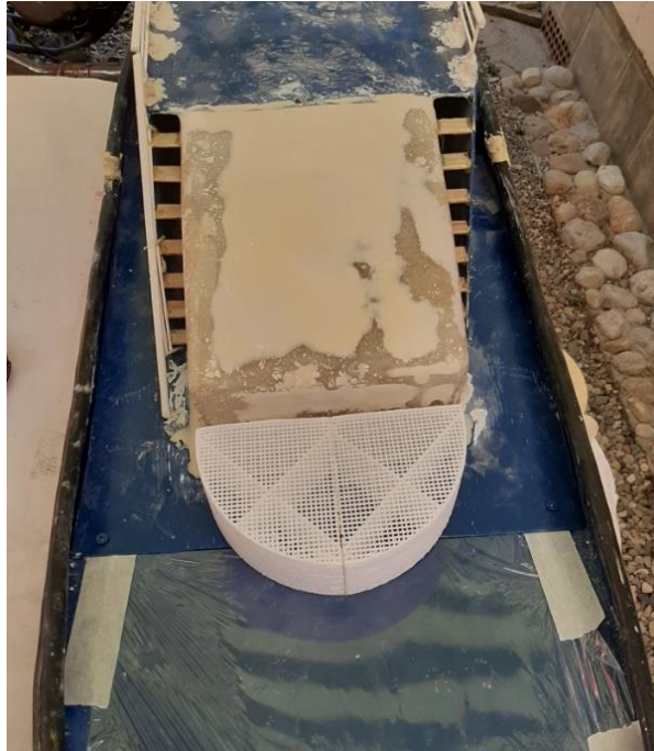
Figura 121. Colocación film en cubierta (Fuente: Propia)
