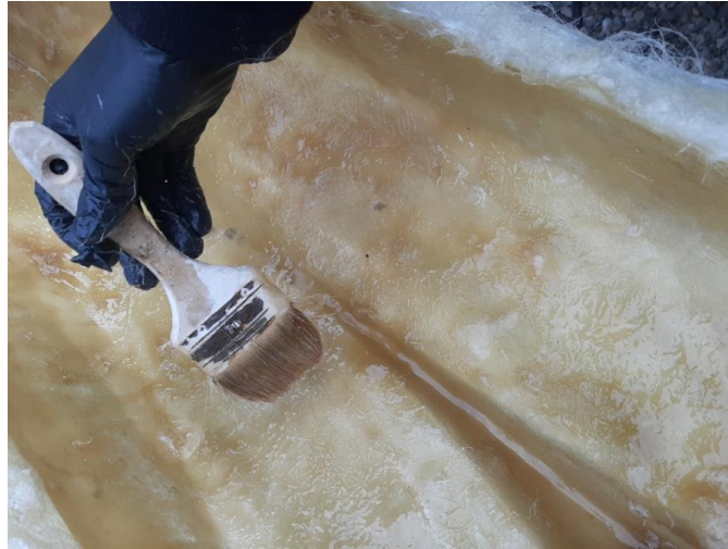
Figura 89. Aplicación resina (Fuente: Propia)
