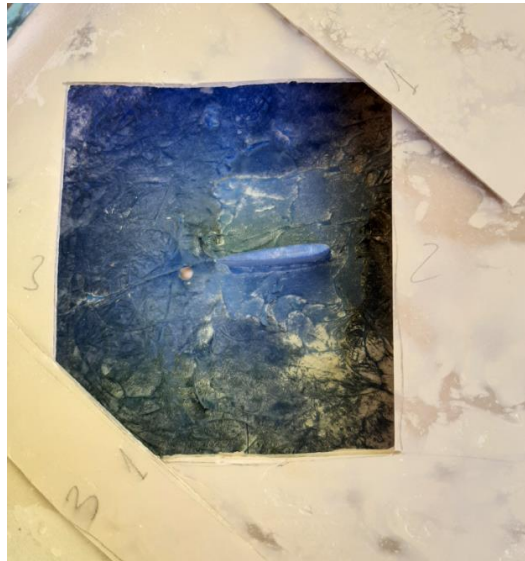
Figura 110. Tapa registro cubierta de popa (Fuente: Propia)
