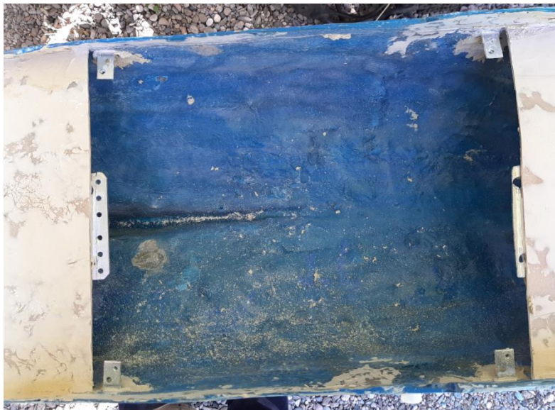
Figura 109. Anclajes cubierta central (Fuente: Propia)
