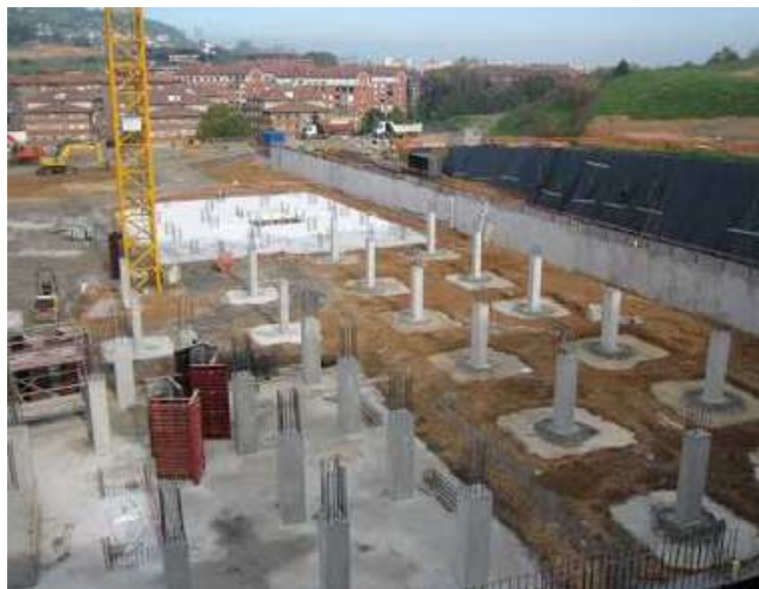
Imagen 21: Ejemplo de preparación de base para la nave
