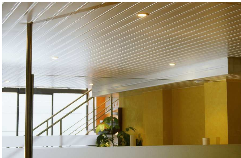
Imagen 26: Ejemplo imagen de falso techo de oficinas
