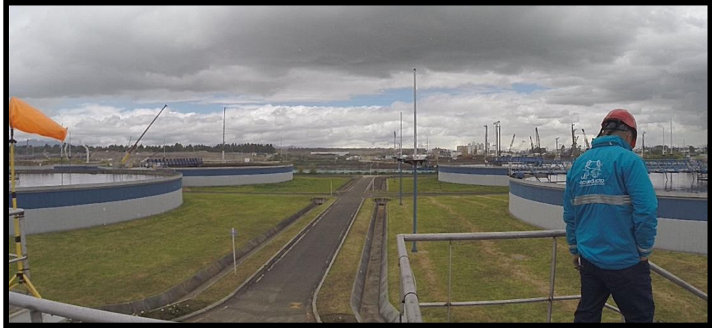
Figura 4.10 Vista panorámica de los tanques decantadores. Fuente: Fotografía de elaboración propia.
