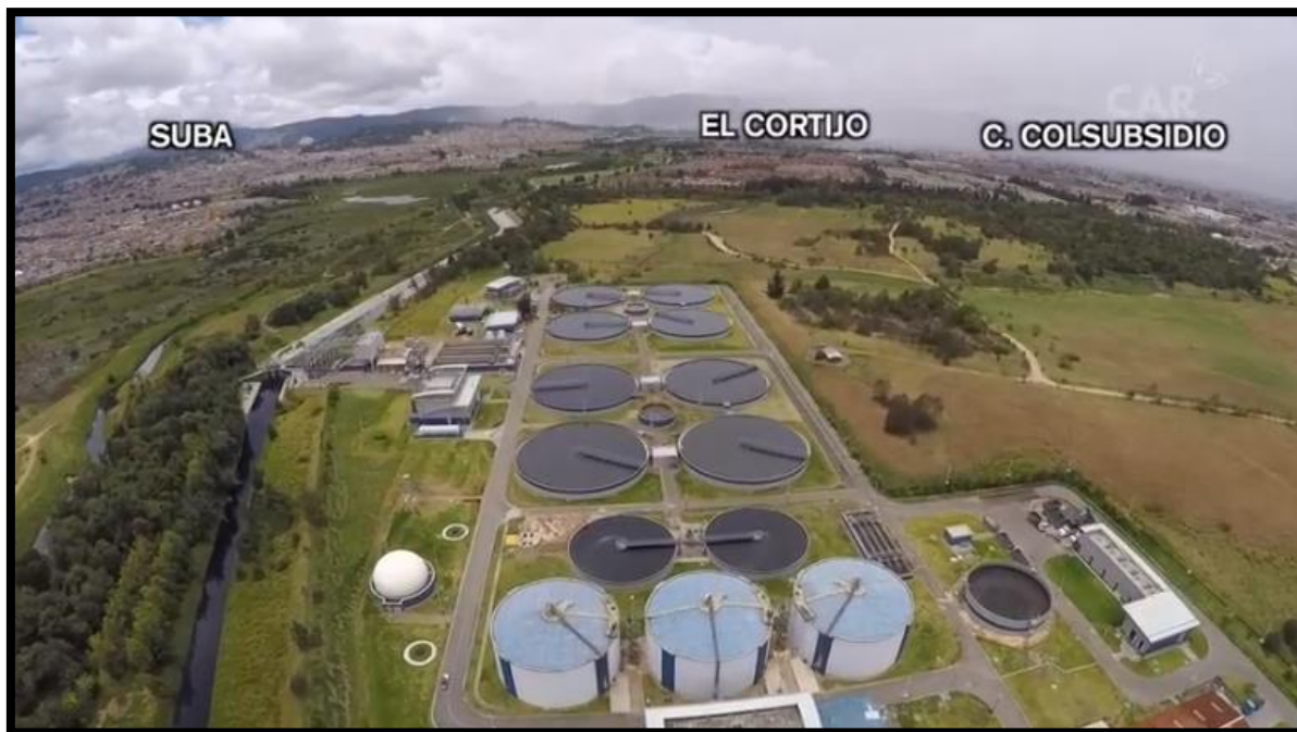
Figura 4.3 Vista superior de la planta de tratamiento de residuos el salitre. Fuente: Corporación autónoma regional.
