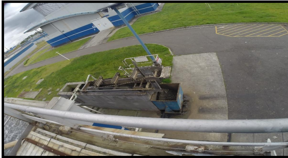
Figura 4.7 Tolva de recolección del proceso de cribado. Fuente: Fotografía de elaboración propia.
