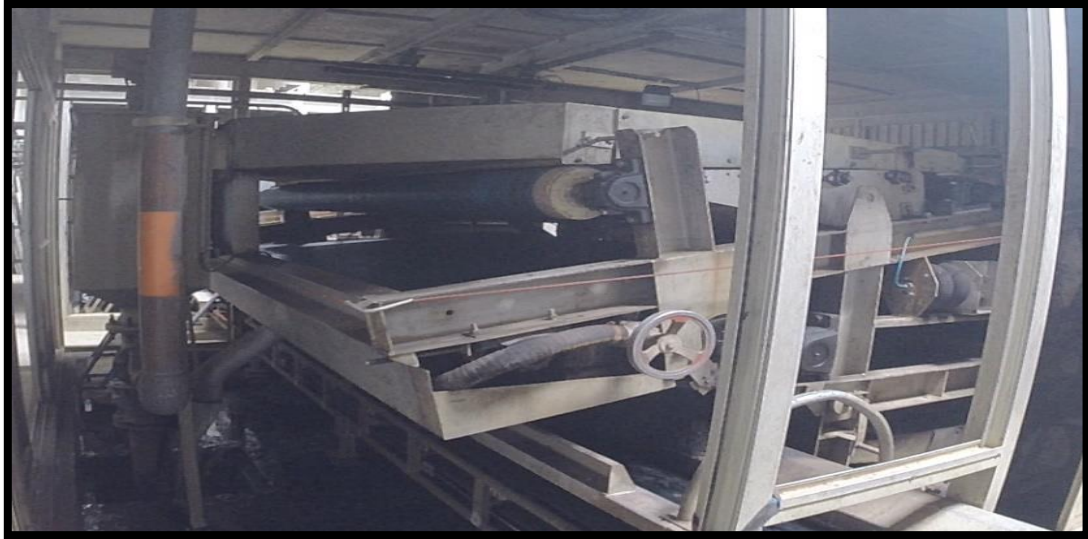
Figura 4.11 Deshidratación del fango por filtro de bandas. Fuente: Fotografía de elaboración propia.
