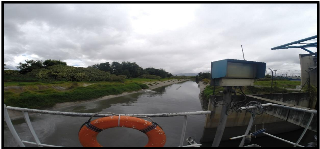
Figura 4.4 Canal de entrada de agua residual de Bogotá. Fuente: Fotografía de elaboración propia.
