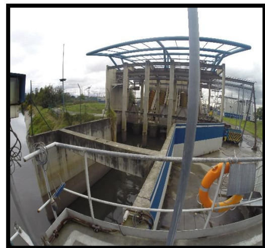
Figura 4.6 Entrada de toma de agua residual y bombeo. Fuente: Fotografía de elaboración propia.
