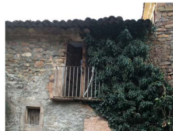
Envall. (Torre de Cabdella)
