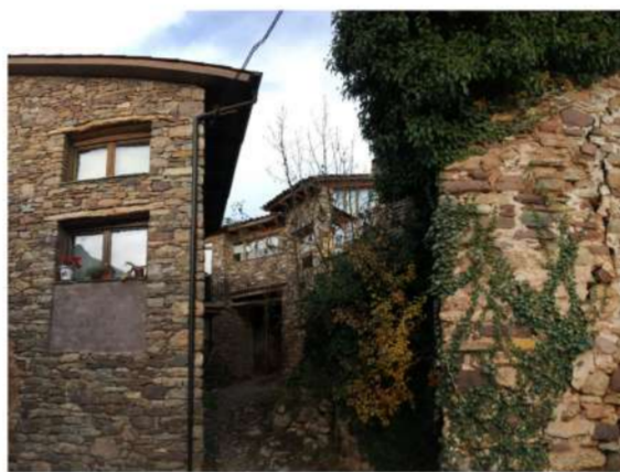
Envall. (Torre de Cabdella)
