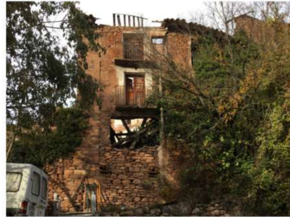
Envall. (Torre de Cabdella)
