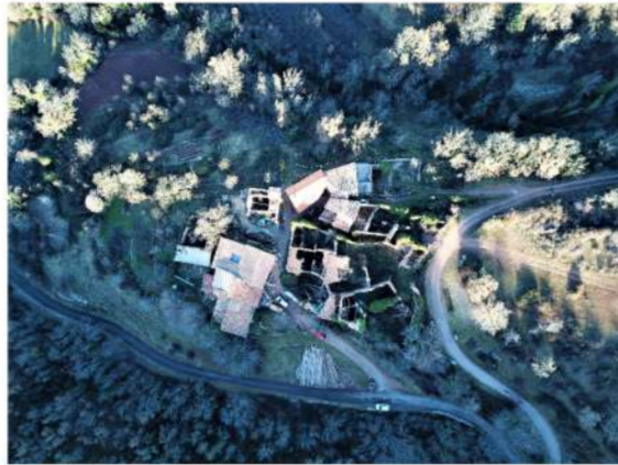
Envall. (Torre de Cabdella)
