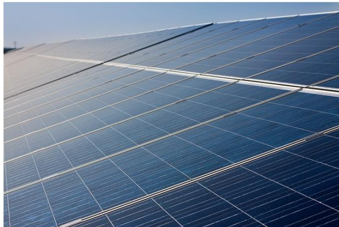
Figura 4: Foto on es veu l'aspecte d'unes plaques policristal·lines
