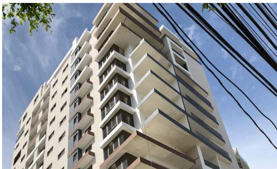
Figura V.1.1 Torre ubicada en el Ensanche Piantini, del Distrito Nacional.
