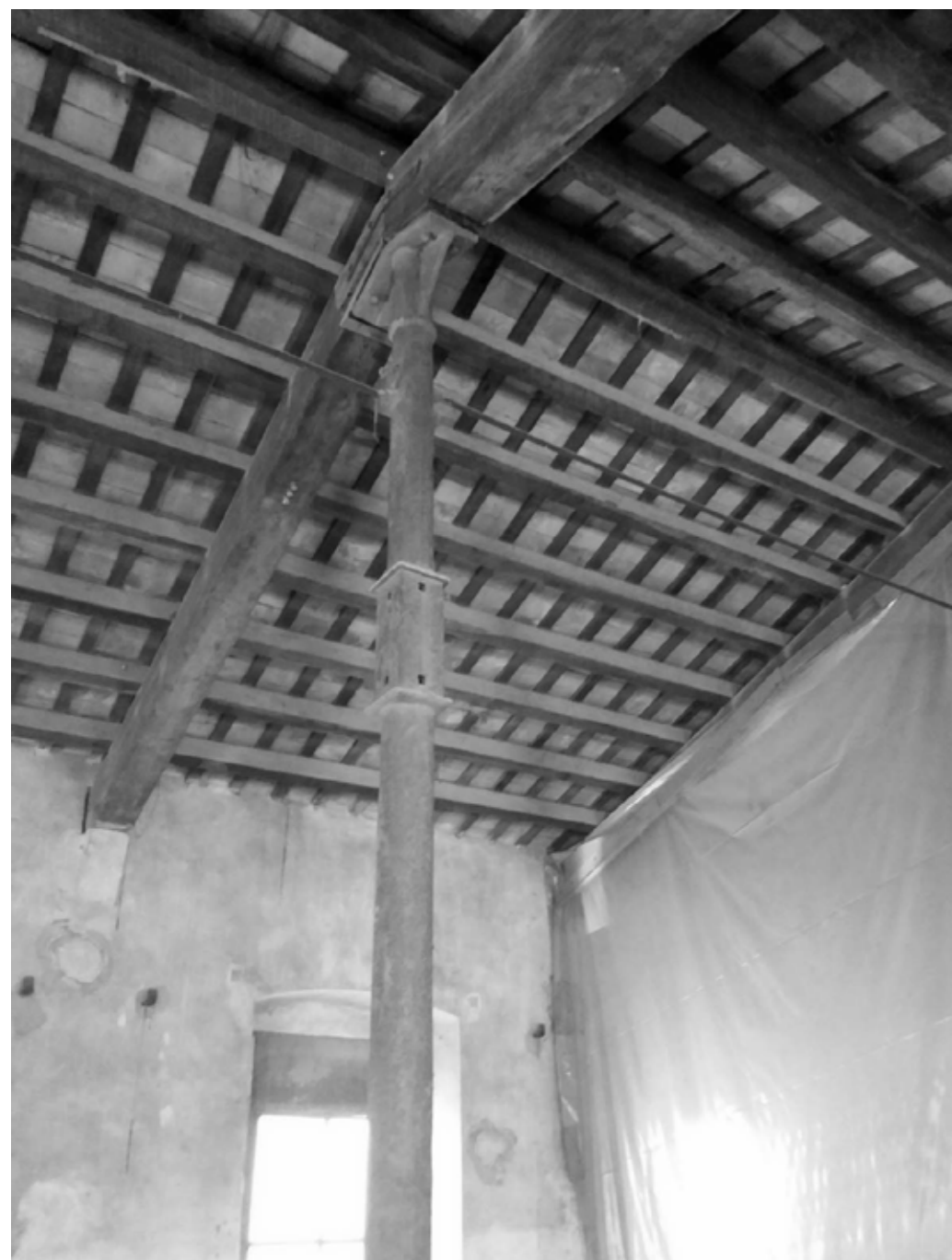
Detall pilar, jàssera i forjat de biguetes i revoltons P2
