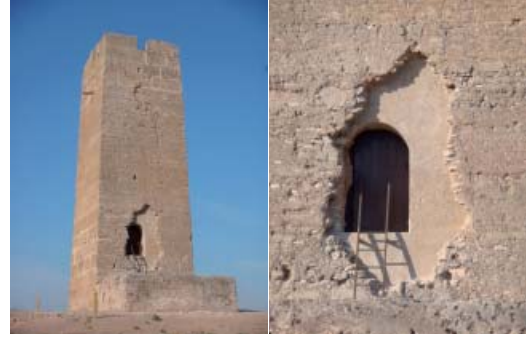
Figura 16. Restauración de la torre de Bofilla de Bétera. Valencia, España. (Fuente: Mileto & Vegas).
