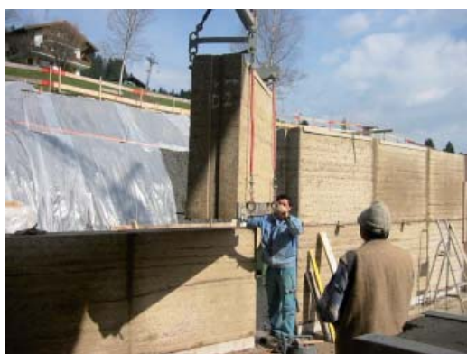
Figura 5. Construcción prefabricada en tapia. (Fuente: M. Rauch).
