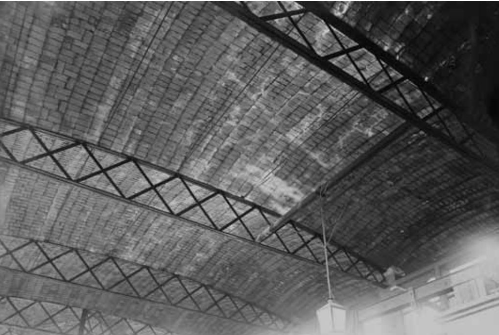
Taller de Can Torras dels Ferros a Poblenuu cobert amb jàsseres de perfil parabòlic al cordó comprimit per rebre les voltes de maó pla (abans de 1910)
