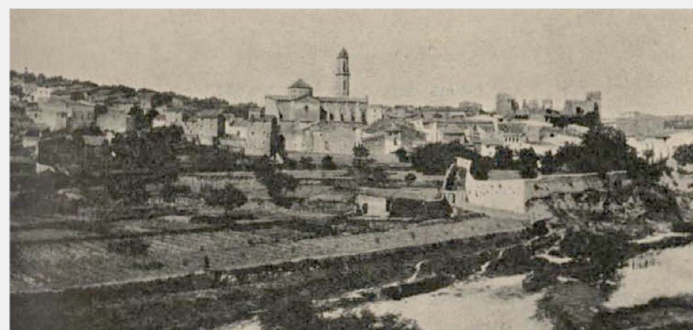
Catllar. Vista general. Cinié de A. Güters
