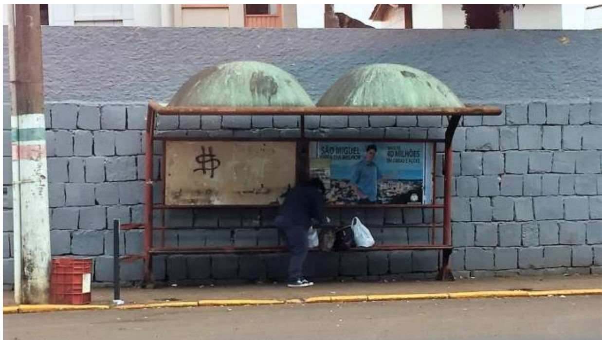
Figura 6: Ponto de ônibus com abrigo Fonte: a autora (06/06/2016)
