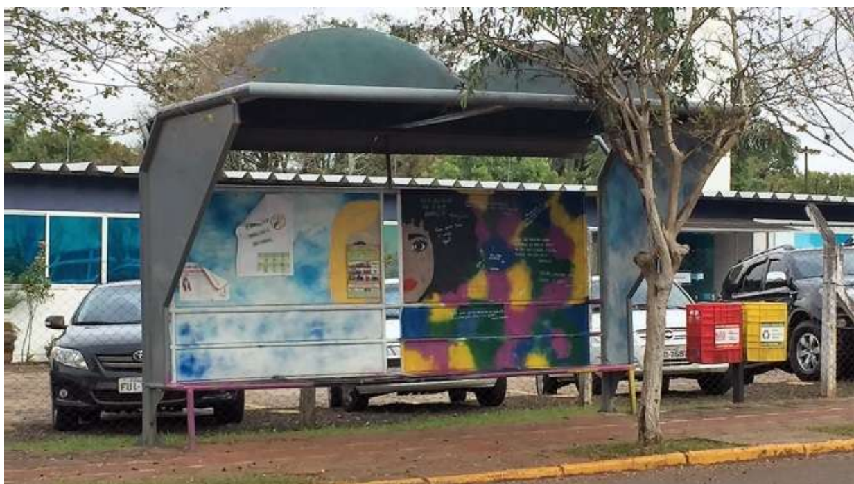
Figura 7: Ponto de ônibus com abrigo Fonte: a autora (06/06/2016)
