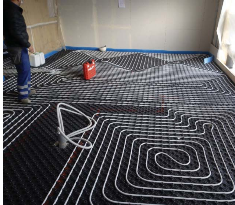
ACS, i terra radiant/refrescant en planta baixa i fan coils (a l'esquerra) a la primera planta de l'edifici de Sant Cugat amb certificació energètica A
