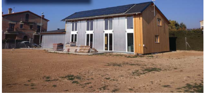
Habitatge unifamiliar d'energia positiva a Anglesola de Josep Bunyesc, amb sistemes constructius passius i actius de captació solar
