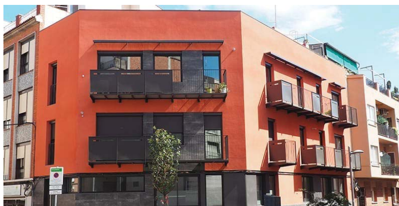
Edifici residencial NZEB de Barcelona amb instal·lacions de Baxi
