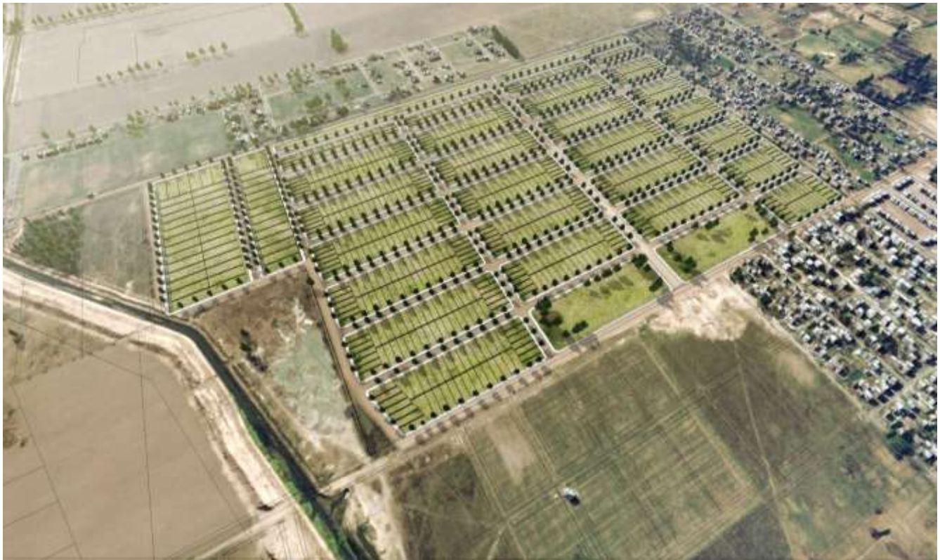
Imagen 1. Parque Habitacional Ibarlucea: Etapa 1 Fuente: La Capital, 2013.
