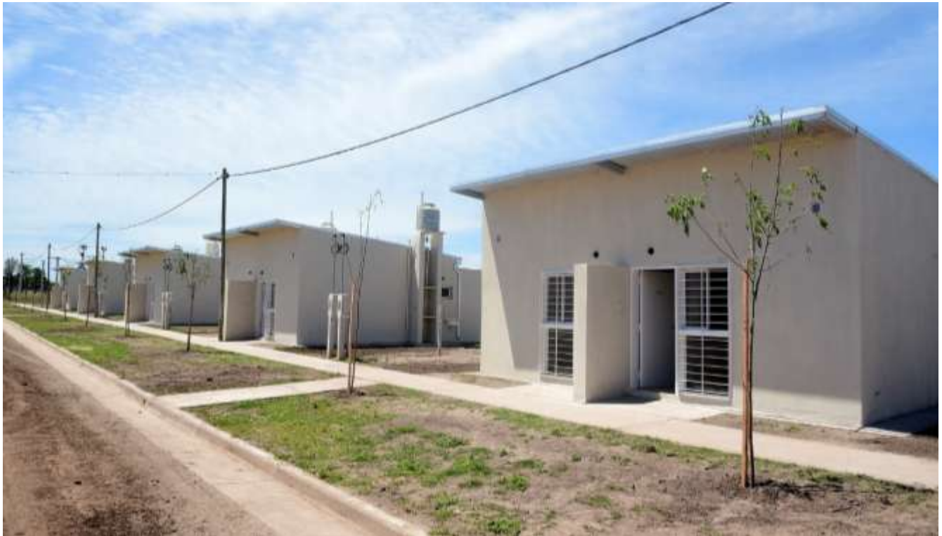
Imagen 5. Viviendas en Parque Habitacional Ibarlucea
