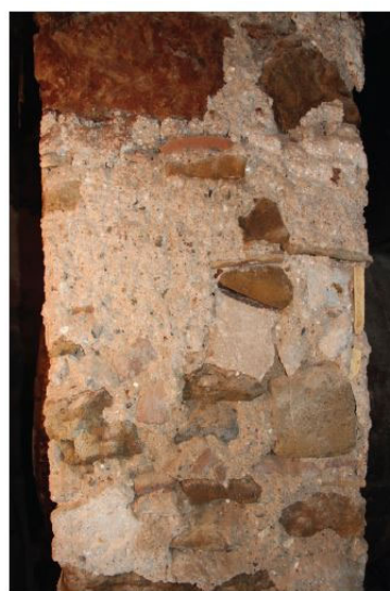
1-2-3: Talarn: sostre de revoltó de guix, pilar de maçoneria i guix i paret de tàpia amb maçoneria de guix
