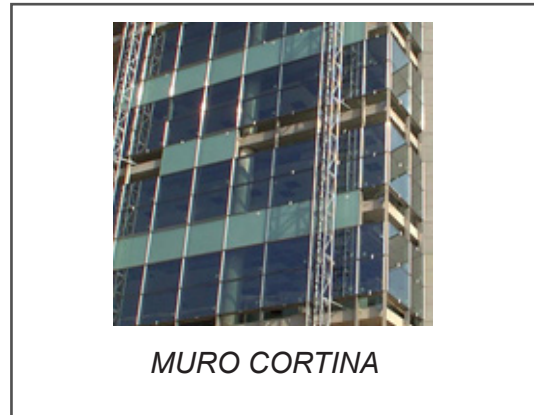
Figura 1.8. Muro cortina Fuente: imagen propia
