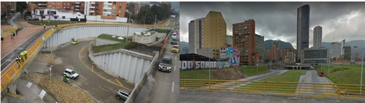
Deprimido de la Calle 94
