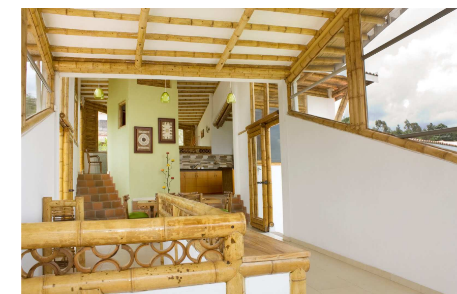
Aplicación del bambú tanto en la estructura de la viviendas como en la carpintería y el mobiliario.
