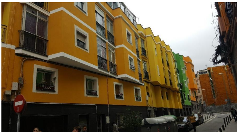
Figura 3. Vista de la intervención terminada
