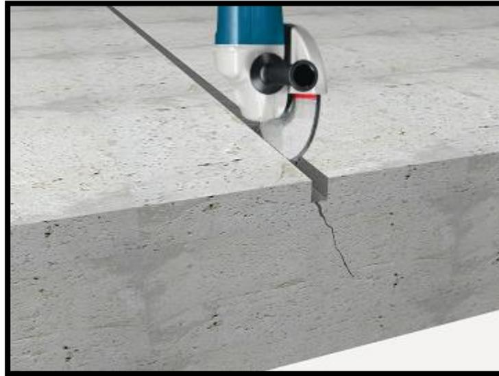
**Figura 5.4** Abertura de fisura para inyección. (CYPE ingenieros S.A., 2017)
