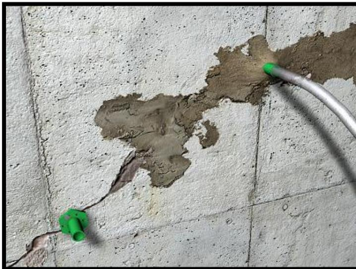
**Figura 5.7** Inyección de fisuras. (CYPE ingenieros S.A., 2017)
