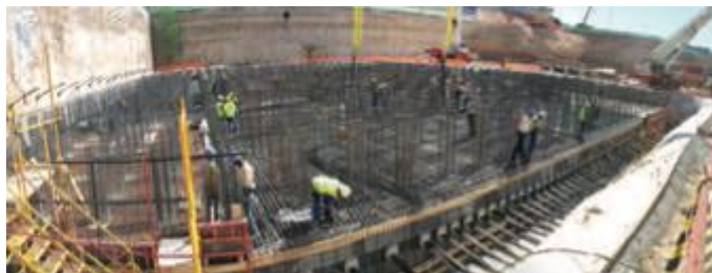
Fig. 2.4.5. Ejecución de la Torre Espacio [5]
