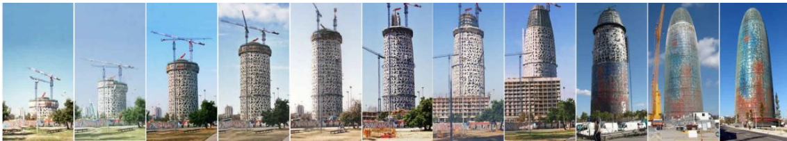
Fig. 2.4.1. Construcción de la Torre Glòries (Barcelona)
