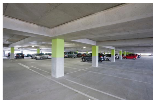
Fig. 2.4.11. Aparcamiento del centro comercial Sylvia Park [8]
