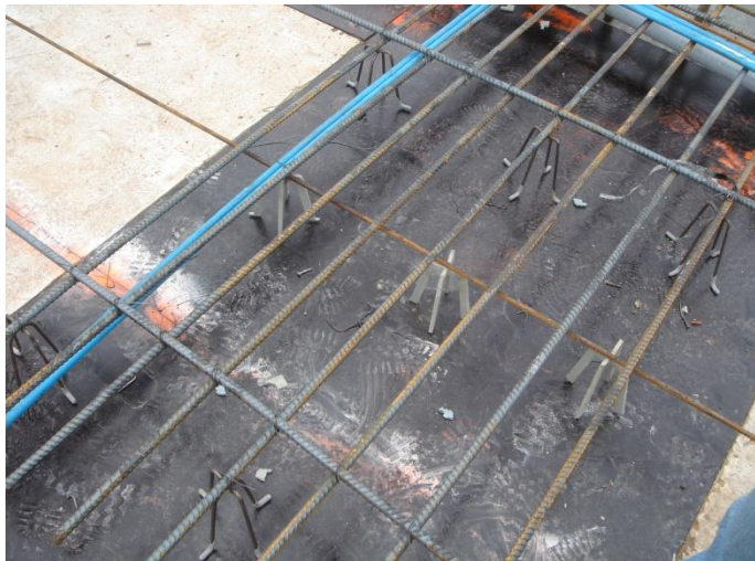
Fig.4.4.2. Disposición de sillas como soporte de armadura pasiva superior.
