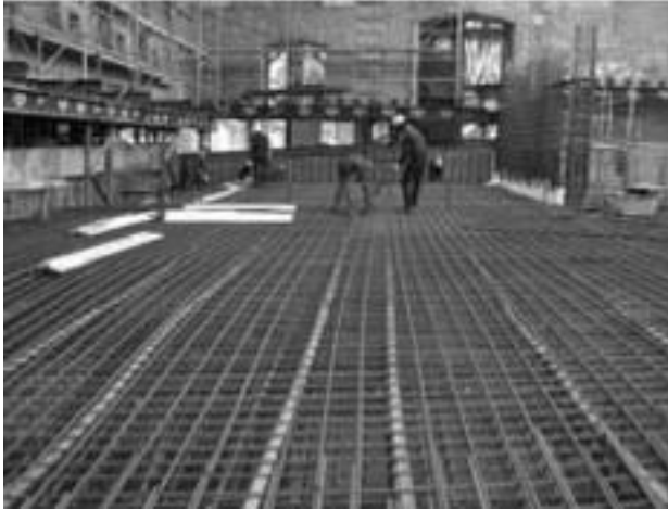
Fig. 2.4.7 Ejecución CaixaForum (Madrid).
