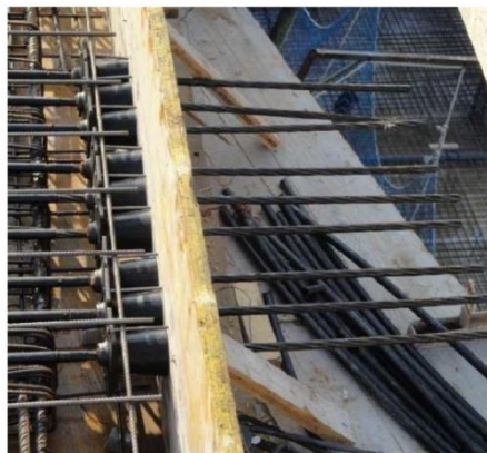
Fig.4.4.1.. Zona de anclajes activos a espera de inicio de tesado
