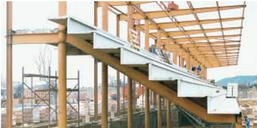
Detalle de gradas sobre estructura metálica (pista de atletismo en GUADALAJARA)
