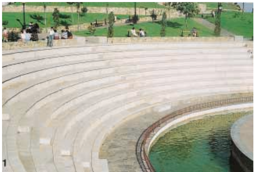
Graderio sobre terreno natural en SESTAO (VIZCAYA)
