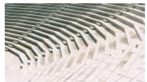
Detalle de graderio con peldaños
