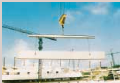
Detalle de montaje con balancín
