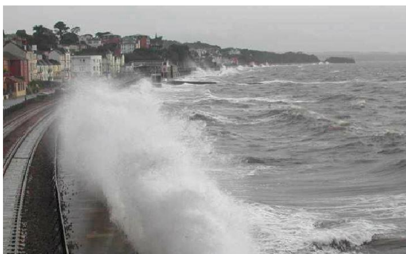
FIGURA 3: exemple d'ultrapassament de la tipologia "white water"[4]
