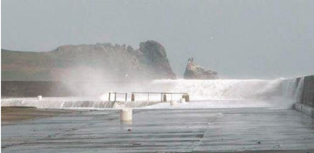
FIGURA 4: exemple d'ultrapassament de la tipologia "green water" [3]
