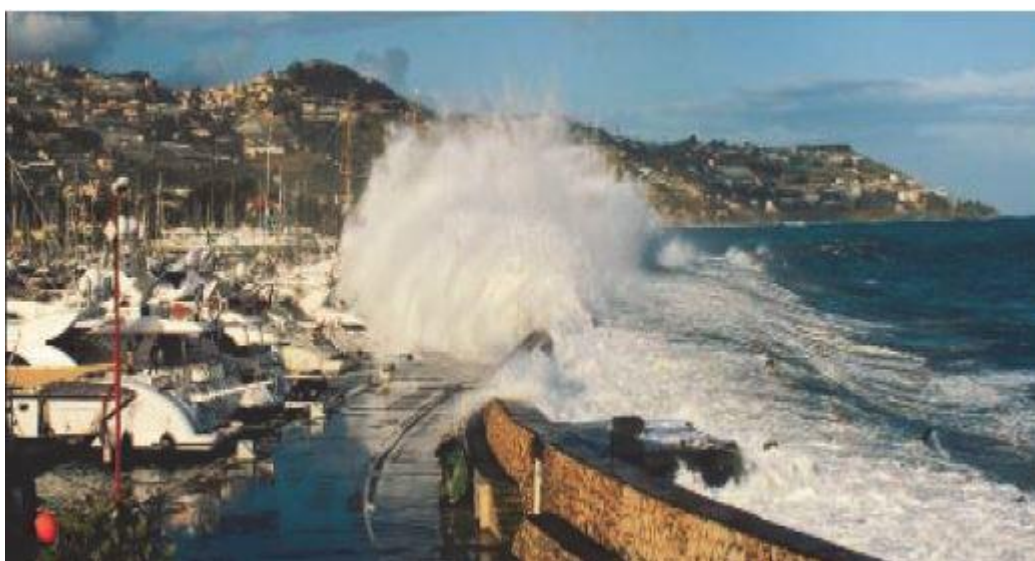
FIGURA 1: Overtopping produint-se a San Remo, Itàlia [3]
