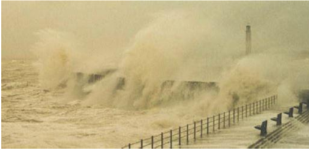
FIGURA 5: exemple d'ultrapassament de la tipologia "spray" [3]
