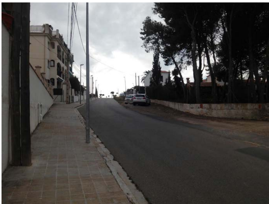
Figura 12.3: Situación de los soportes en la acera del tramo 1
