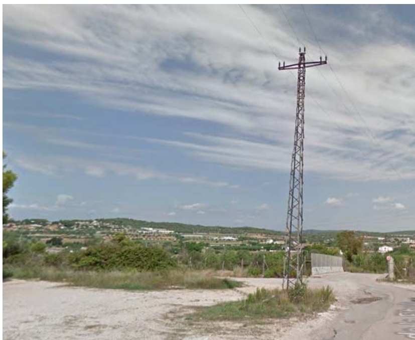
Figura 12.1: Situación de la torre eléctrica
