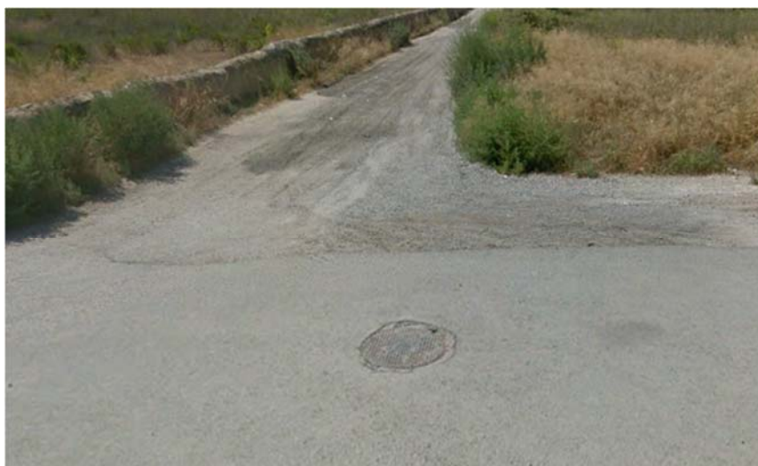
Figura 8.21: Punto de conexión de drenaje longitudinal
