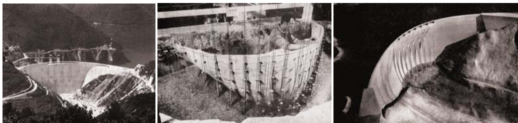
L'obra recentment acabada al costat dels treballs d'encofrat del model reduït per a l'estudi tensional de la volta i el model reduït per a l'estudi del comportament hidràulic del sobreexidor Fotografia Brangulí, Rebollo Alonso, Arturo. Ingeniería y arquitectura del hormigón: instantáneas sobre el salto de Susqueda . Barcelona: Editores Técnicos Asociados, 1974, p. 83 Fotografía Ismes. Rebollo Alonso, 1972, p. 292 Fotografía Brangulí, Rebollo Alonso, 1972, p. 81
