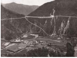
La tancada de Susqueda amb un possible encaix de la volta
