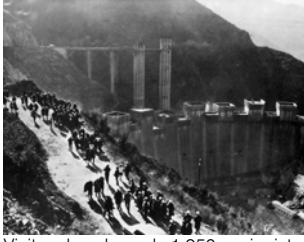
Visita a les obres de 1.950 accionistes, durant la junta general a peu d'obra el 1967 Hidroeléctrica de Cataluña (ed.). Memoria y balance: correspondiente al ejercicio de 1967 . Barcelona: Hidroeléctrica de Cataluña, 1967
