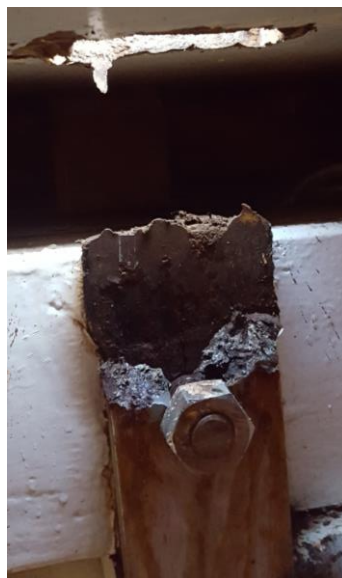
Ilustración 116. Cadenote partido bajo cubierta. Fuente: Propia
