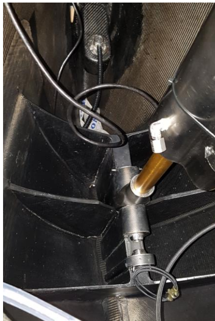
Ilustración 28. Refuerzo estructural en la roda. Fuente: Propia
