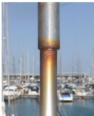
Ilustración 97. Área oxidada en jarcia de varilla. Fuente Propia
