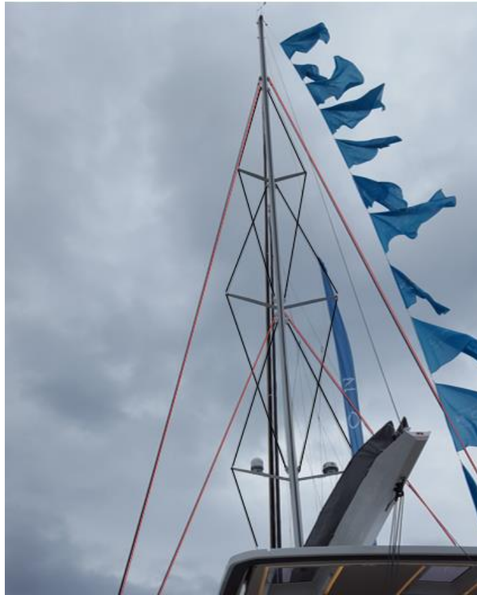
Ilustración 21. Estructura de diamante con tres pisos de crucetas. Fuente: Propia
