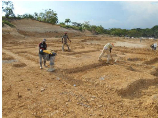
Ilustración 12 Proceso de cimentación
