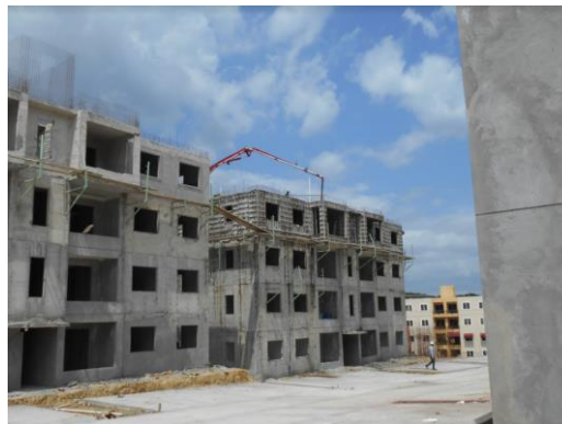
Ilustración 18 Fase de hormigonado
