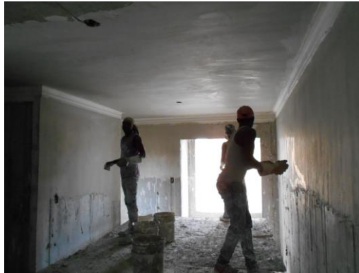
Ilustración 21 Revestimiento interior
