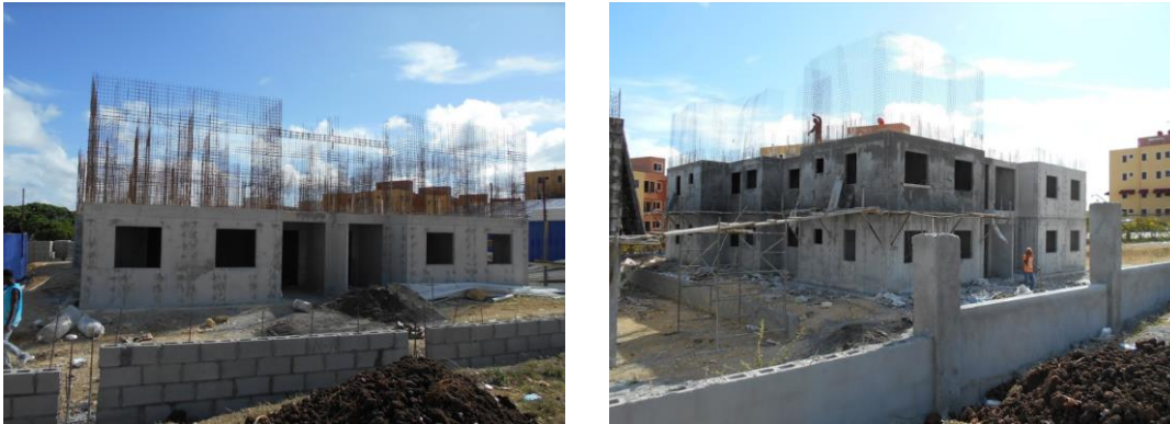
Ilustración 15 Armado vertical
