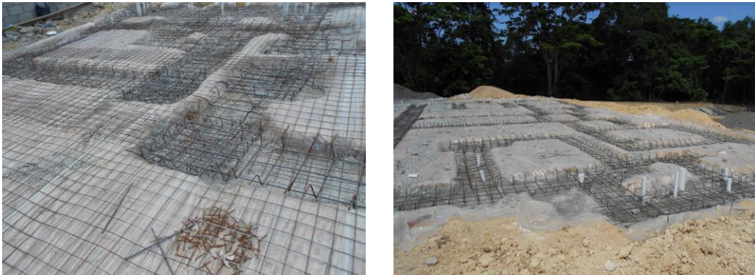
Ilustración 13 Proceso de armado de cimentación
