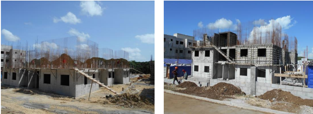
Ilustración 19 Continuación de armado
