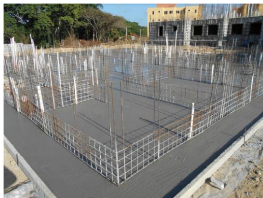
Ilustración 14 Hormigonado de platea
