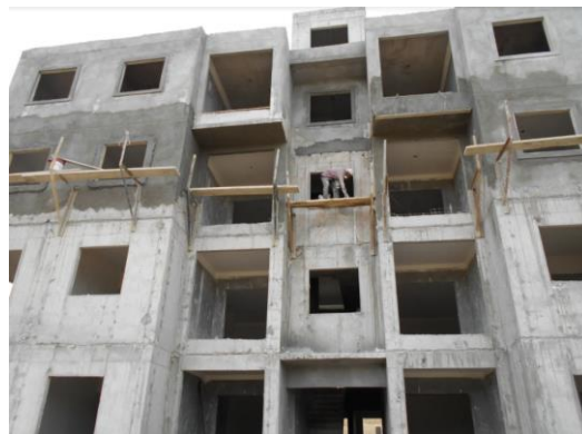
Ilustración 20 Revestimiento exterior
