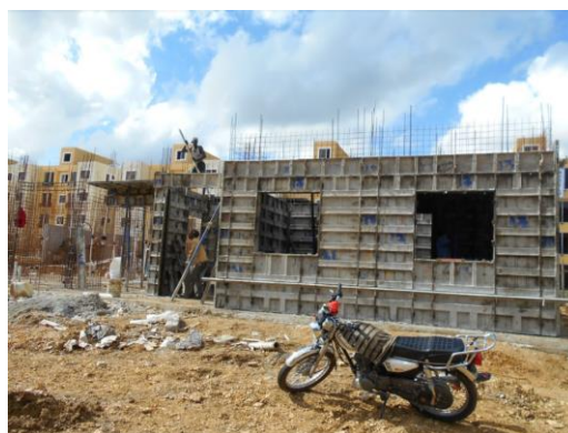
Ilustración 16 Fase de encofrado
