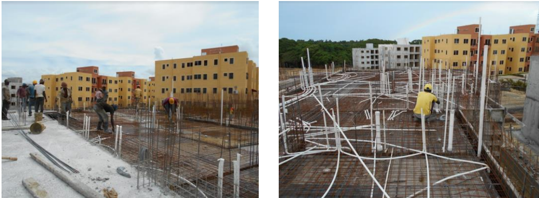
Ilustración 17 Armado de losa
