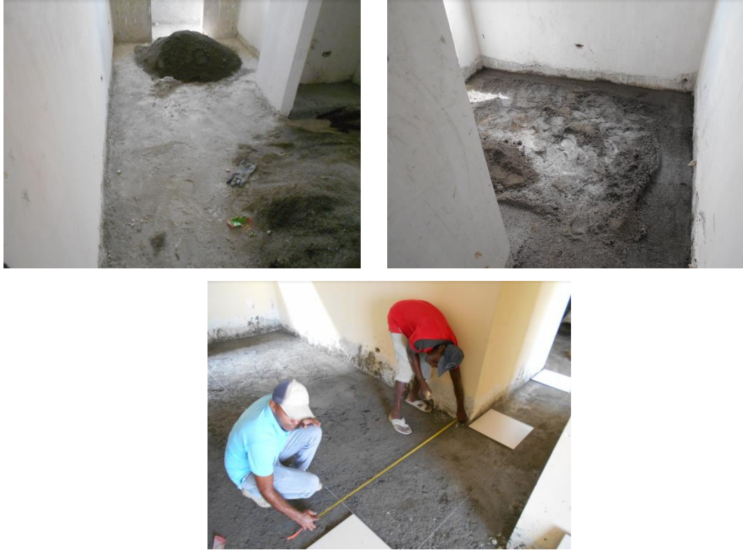
Ilustración 22 Fase de colocación de pisos
