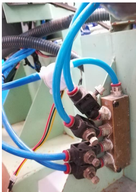
Ilustración 44: Repartición de caudales en las celdas de flotación
