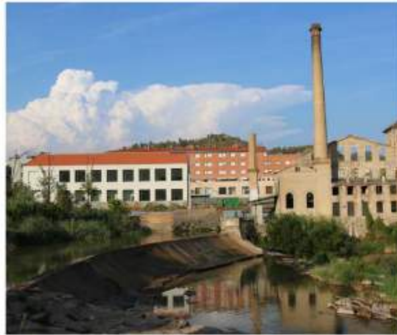
La zona de la Fàbrica Vella, amb el túnel de col Carrera a l'esquerra i part de l'estructura de la tèxtil a la dreta Foto: N. BADRENAS.
