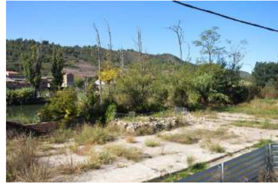
11 SOLERA D'ANTIGA NAU. Estat deteriorat i creixement espontani de vegetació
