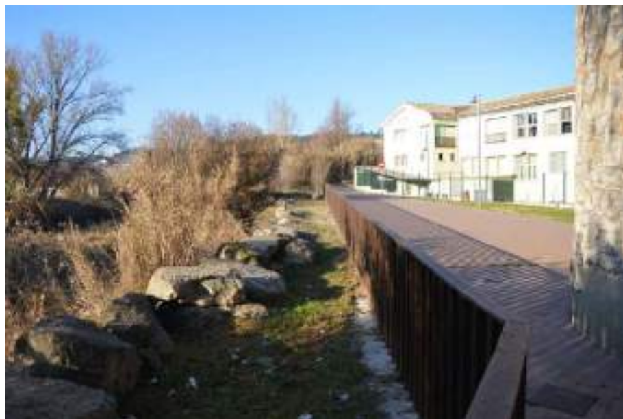
6 ZONA NORD. Escullera de la Torre del Gas
