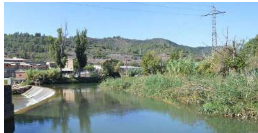
8 PLATJA DE SEDIMENTS. Vista des del mur de la Fàbrica Vella
