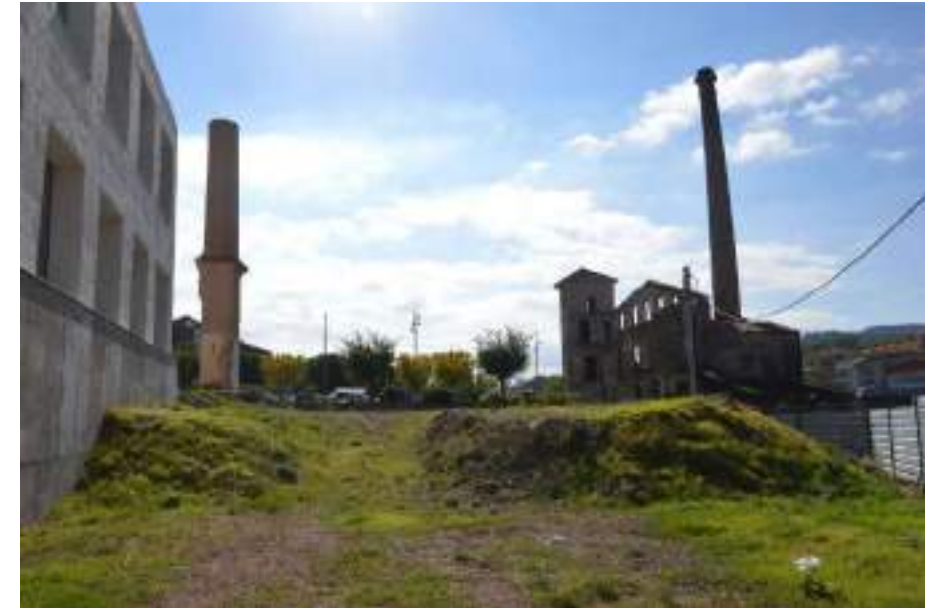
7 CAL CARRERA – FÀBRICA VELLA. Estat del talús dels voltants de Cal Carrera
