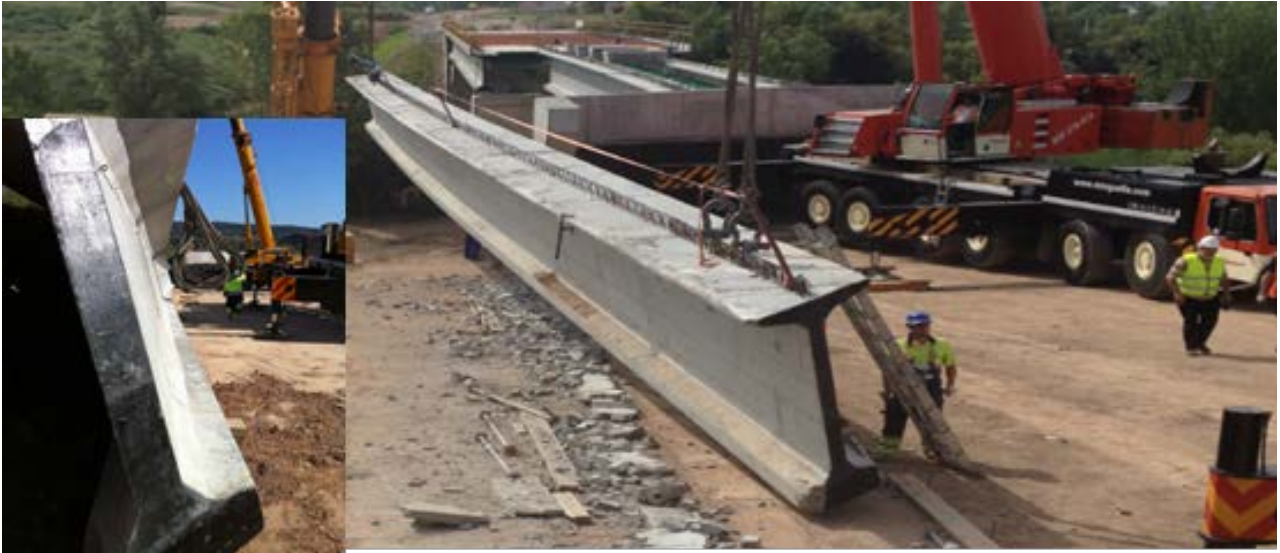
Figura 3. Configuración de izado y deformada.
