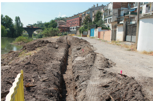
F5.2 Rasa per la instal·lació de les diferents boques de rec.
