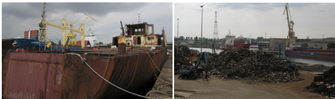
Figura 15. Instalación de reciclaje en el puerto de Szczecin ( http://www.almex-recycling.pl/ )
