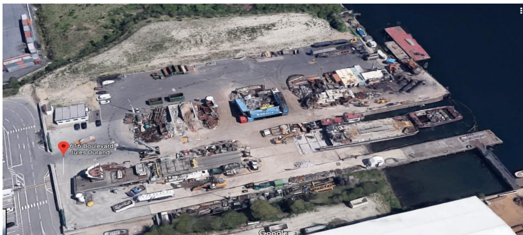
Figura 7. Vistas de la instalación (Google maps- Satélite)
