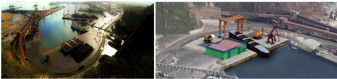
Figura 17. Instalación y rampa de desmantelamiento ( http://www.ddr-vessels.es/index.htm )
