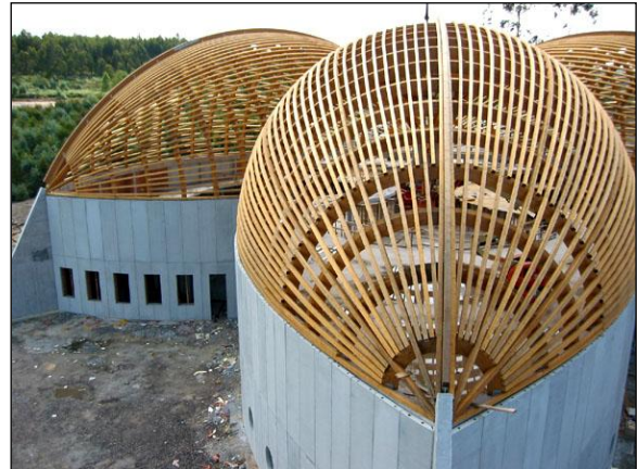
Vista interior i exterior de l'estructura on s'aprecia el disseny de la coberta de fusta laminada.
