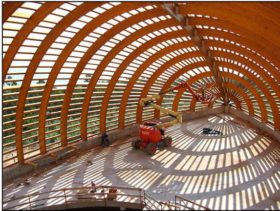
Vista interior i exterior de l'estructura on s'aprecia el disseny de la coberta de fusta laminada.
