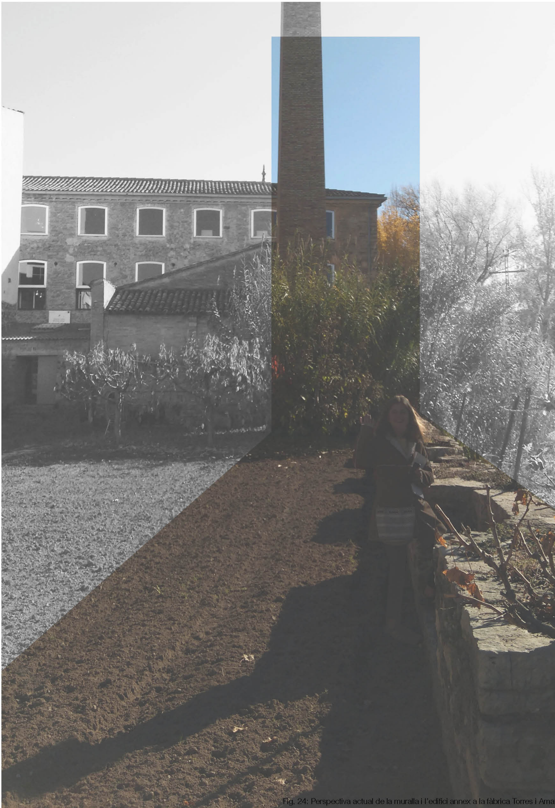
Fig. 24: Perspectiva actual de la muralla i l'edifici annex a la fàbrica Torres i Amat
