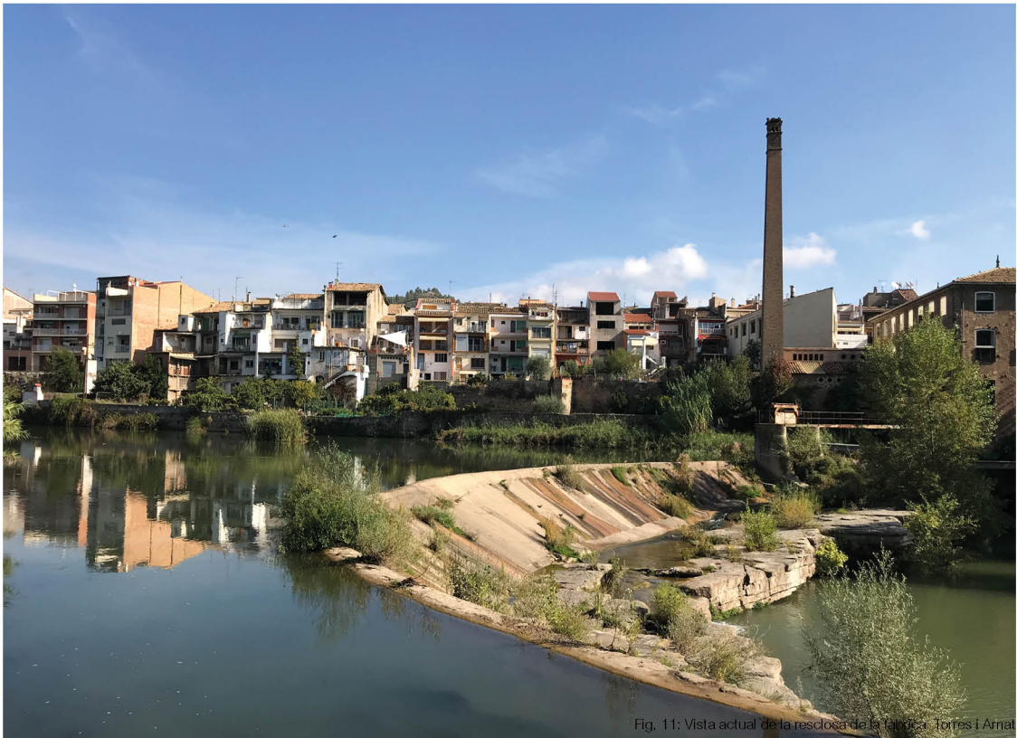
Fig. 11: Vista actual de la resclosa de la fàbrica Torres i Amat
