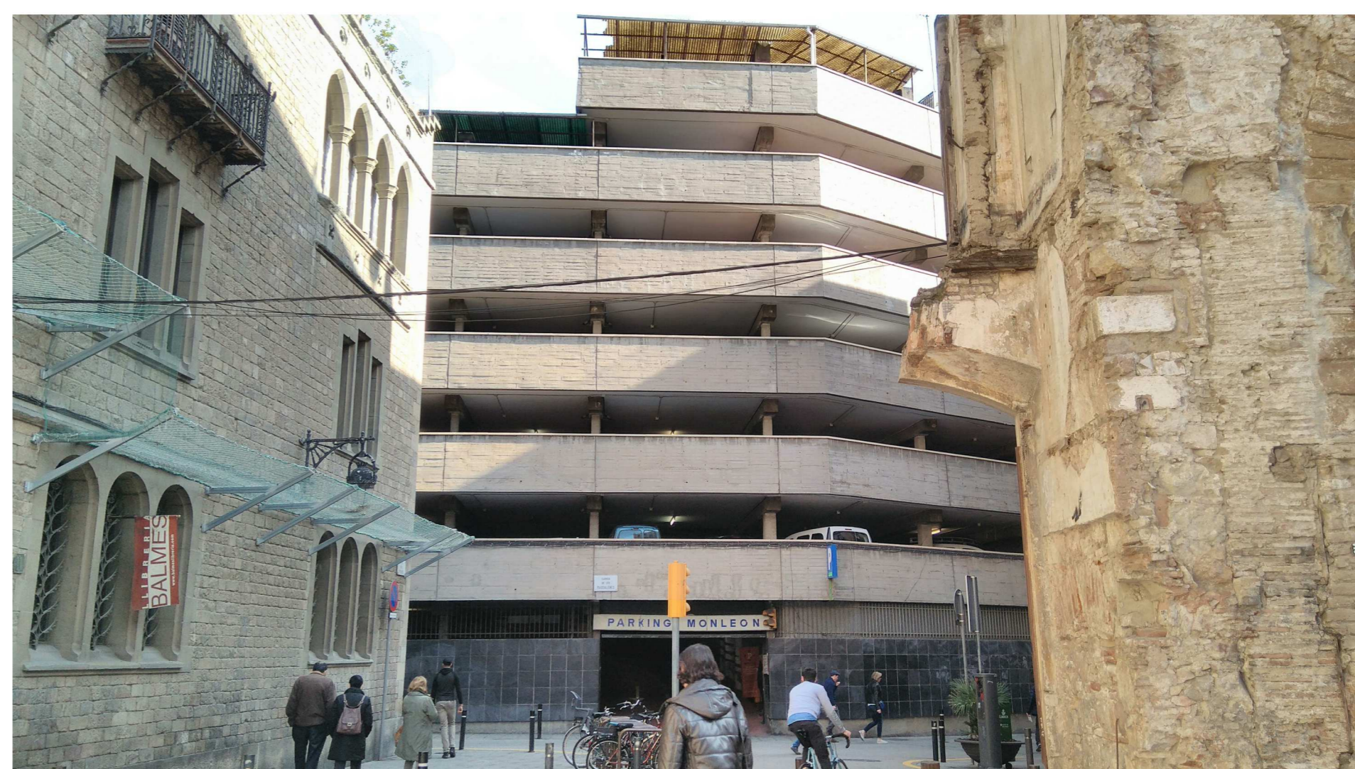
Imagen de estado actual
