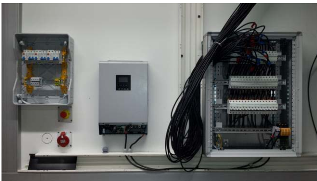
Fig. 8. Montaje correspondiente al antiguo campo fotovoltaico monocristalino de 2,64 kWp. Caja de cargas (izquierda), ondulador híbrido Axpert (centro) y cuadro de interconexiones (configuración N_s = 2 , N_p = 8 ), seccionadores y fusibles de los módulos fotovoltaicos.
