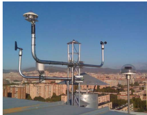
Fig. 9. Aspecto de la estación meteorológica en la sobrecubierta del edificio A de la EEB.
