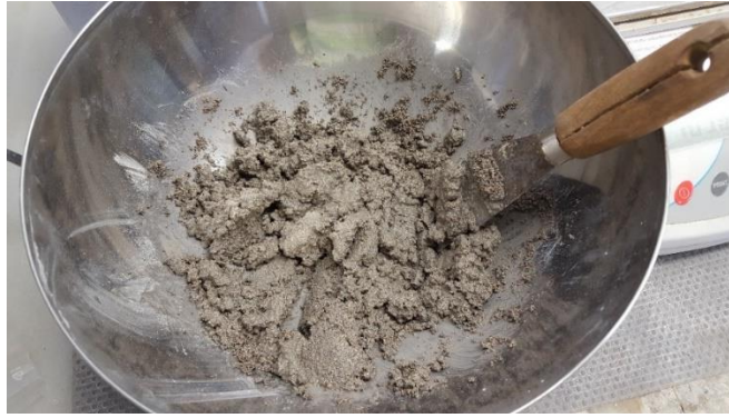
Preparación de la mezcla de mortero - Ilustración 30 Fuente: elaboración propia
