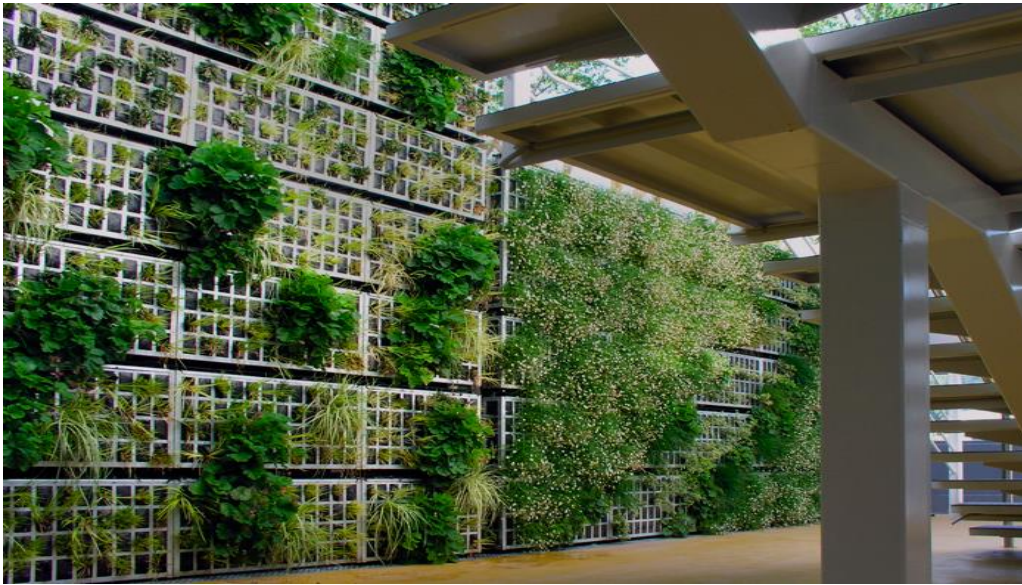
Figura 7. Fachada de enrejados modulares. Fuente: Inarquia.
