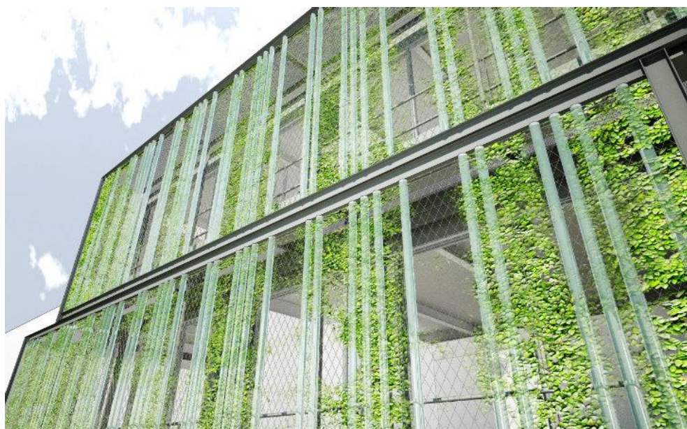
Figura 6. Fachada de doble piel de cables trenzados en Lheman College Day Care-Garrison Architects. Fuente: Inhabitat
