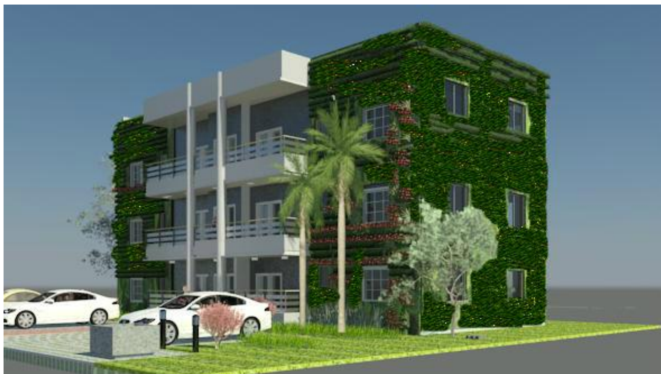
Figura 36. Edificio modelo con fachada verde hidropónica implementada en los primeros dos meses antes que florezcan las plantas de cara lateral
