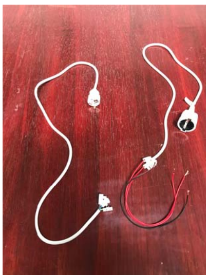
Figura 6.4.3. Fotografia en detall del cable seccionat. Font: Font pròpia.
